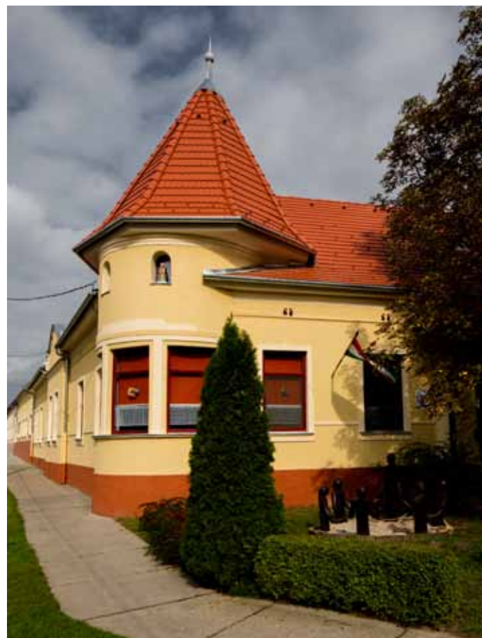
Óvoda Keceli u. 9. (919 hrsz.)
