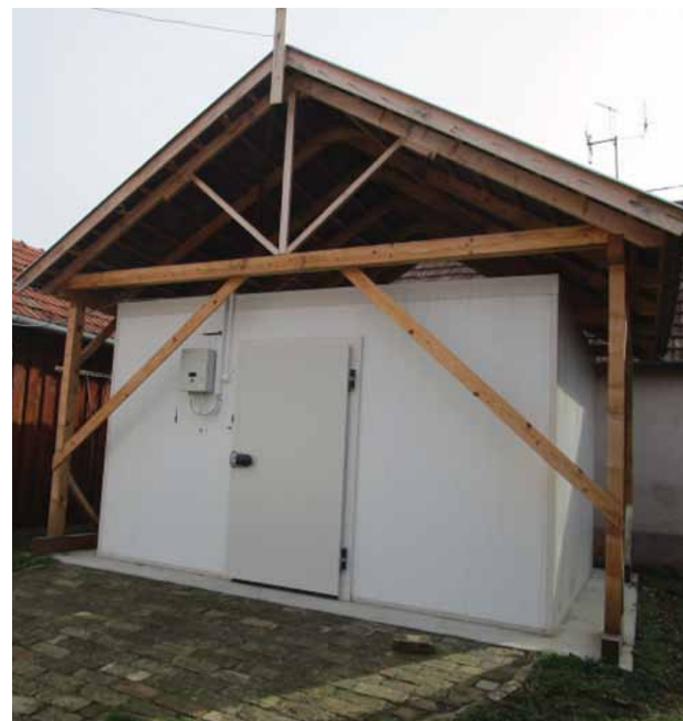
Gépészeti berendezéseket takaró építmények
